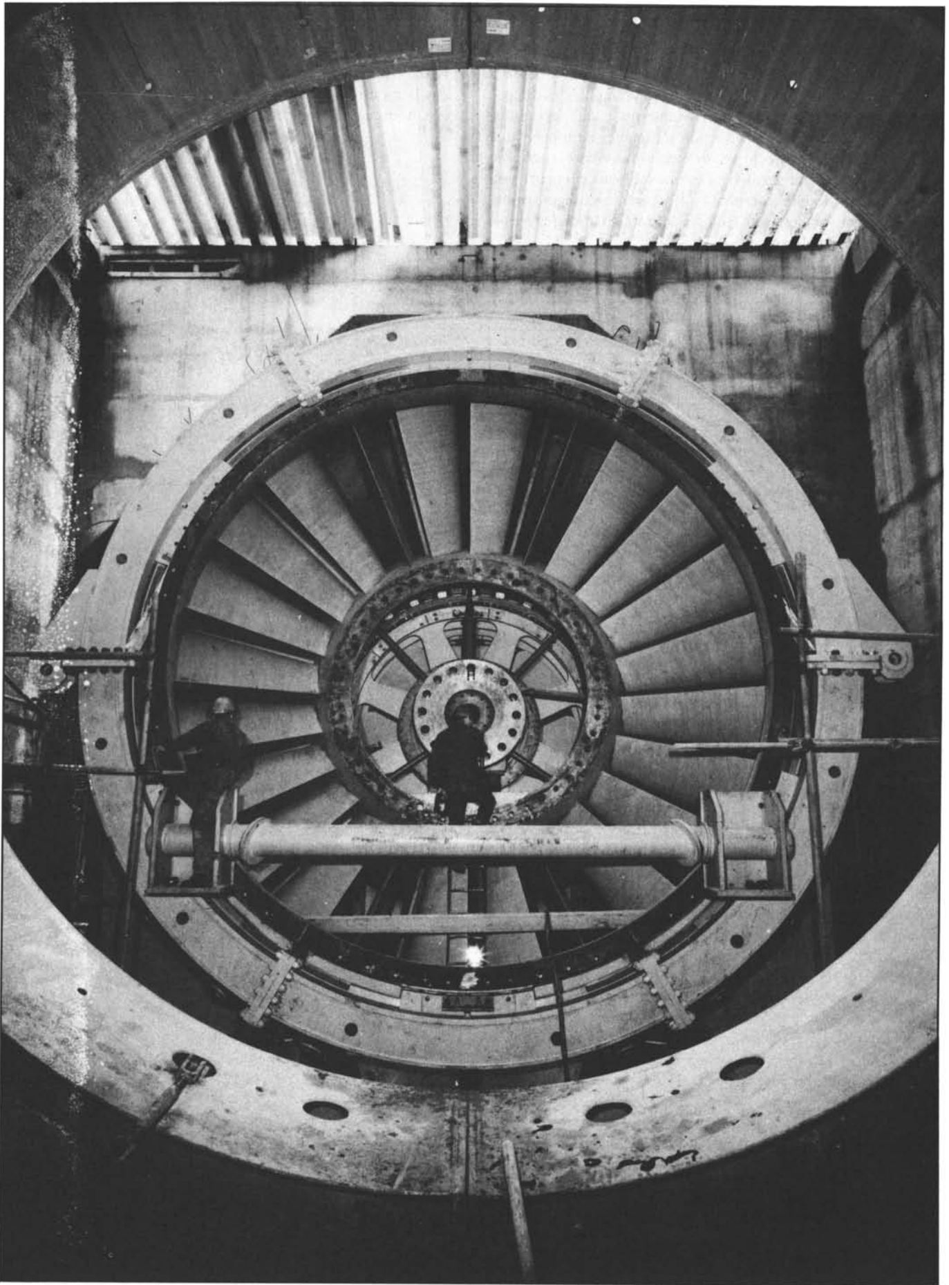
Intérieur d'un des groupes bulbes en cours de montage à l'usine thermique de Strasbourg en 1970.
