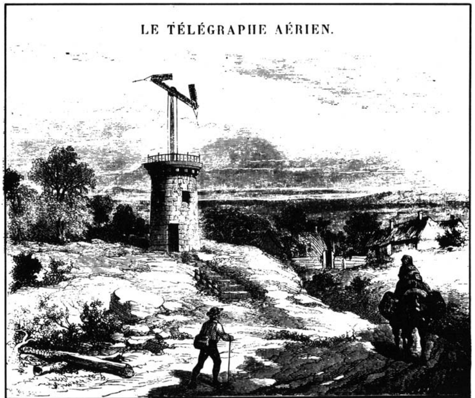
Poste de télégraphie aérienne.
