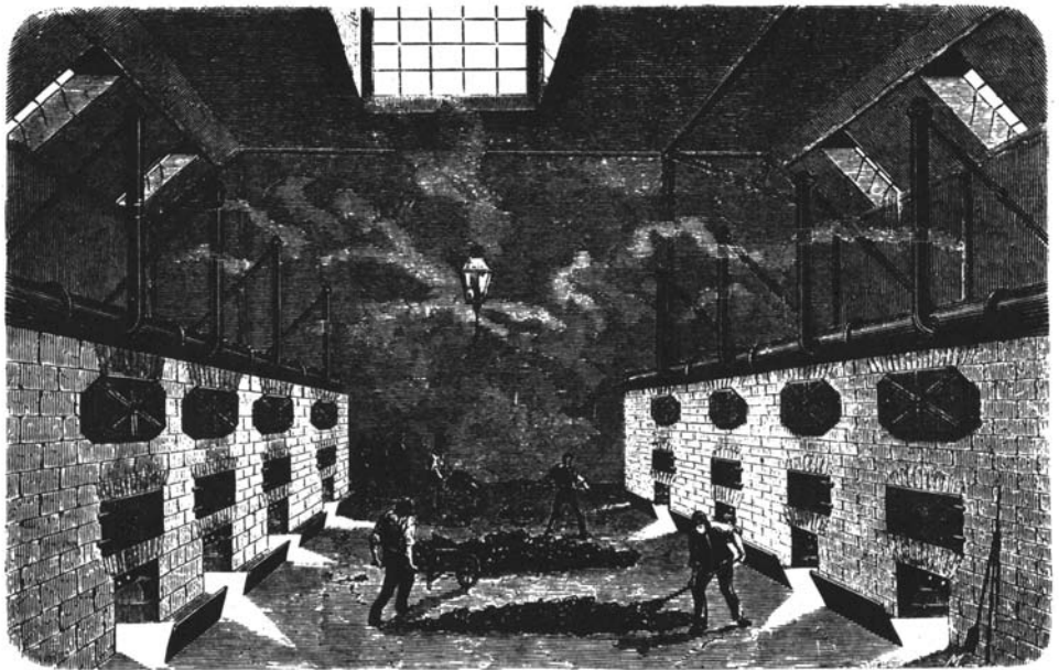
Préparation du gaz d'éclairage, décomposition de la houille par la chaleur
