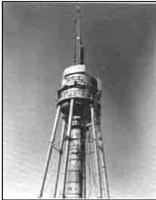
Fig. p. 100. L'érection de la cheminée d'équilibre, élément-signal encore très visible aujourd'hui. Source : La Pulperie de Chicoutimi.
