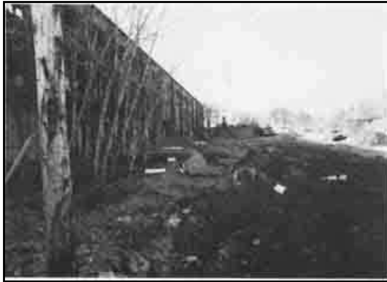
Fig. p. 5a. D'importants travaux sont effectués au début des années '80 afin de restaurer les bâtiments et d'aménager le site. Source : La Pulperie de Chicoutimi.
