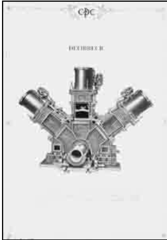
Fig. p. 30. Dessin d'un défibreur. Source : SHS, Catalogue d'appareils et machines de la C.P.C., p. 5.
