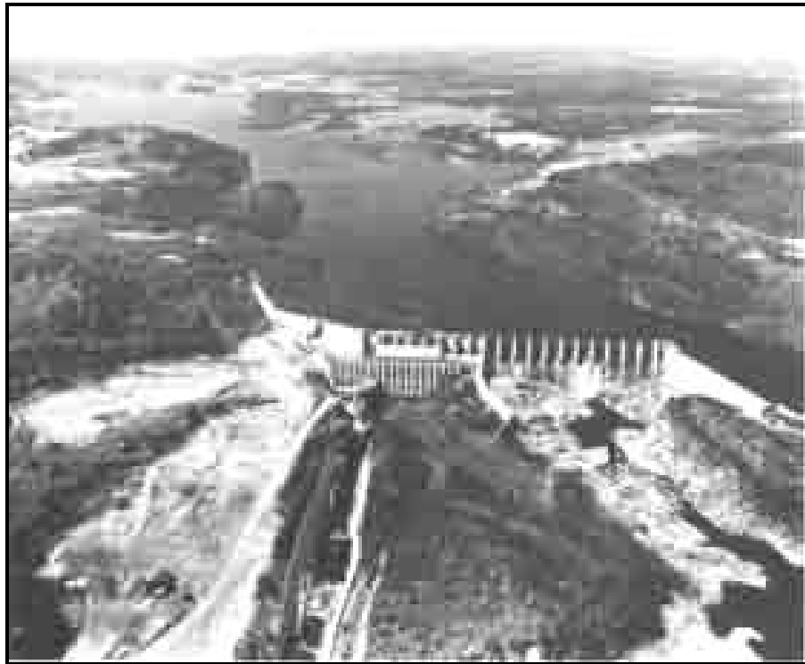
Fig. p. 20. La centrale hydroélectrique de Chute-à-Caron, sur la rivière Saguenay. Source : ANQC, fonds SHS.
