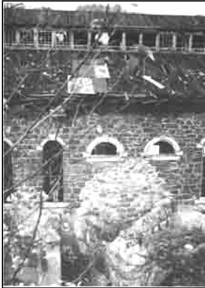
Fig. p. 3. Une partie de l'édifice 1912 qui démontre bien dans quel état lamentable se trouvaient les bâtiments de l'ancienne Compagnie de pulpe de Chicoutimi à la fin des années 70. Source : La Pulperie de Chicoutimi.
