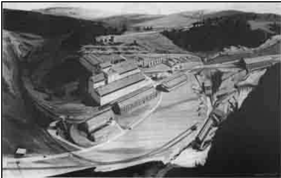
Fig. p. 98. Esquisse du projet de la Eastern Mining and Smelting Corporation. Source : SHS, fonds René-Bélanger.
