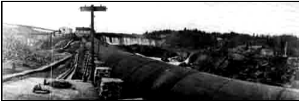
Fig. p. 23a. L'amenée d'eau du moulin #2 fut une réussite d'ingénierie à son ouverture en 1903. Source : ANQC, fonds SHS.
