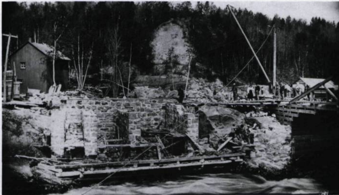
Le site de «l'île électrique» à Chicoutimi vers 1897. En avant-plan, la construction du premier moulin de la Pulperie de Chicoutimi. Œuvre de l'architecte C.E. Eaton et de l'ingénieur Alex Wendler, son aménagement coûtera 125 000 $ et 75 employés seront affectés à la production. En arrière-plan, à gauche, la petite centrale de la Compagnie électrique de Chicoutimi.
