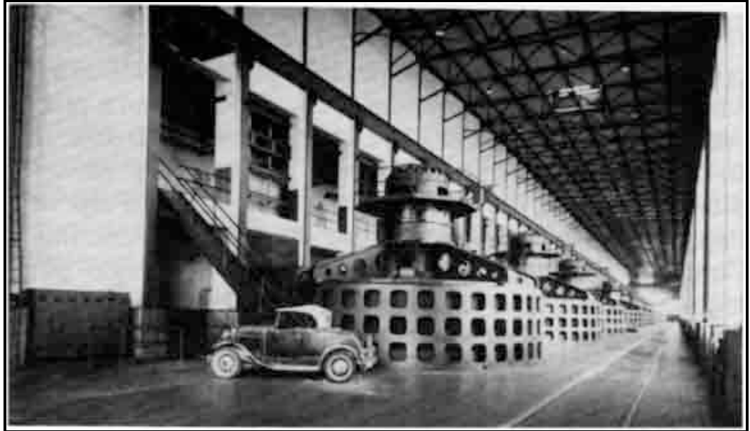
Vue intérieure de la centrale d'Île Maligne, SHLSJ.
