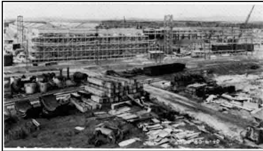
Les travaux d'agrandissement de l'usine d'Alcan à Arvida en 1940, Collection Alcan.
