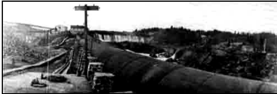
Fig. p. 23a. L'aménée d'eau du moulin #2 fut une réussite d'ingénierie à son ouverture en 1903. Source : ANQC, fonds SHS.
